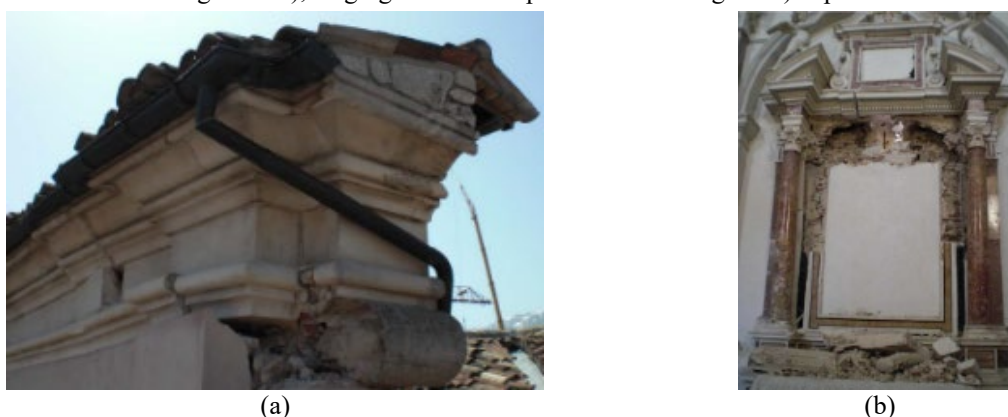
Figura 4 : a) rotazione della vela campanaria, b) inflessione della muratura
