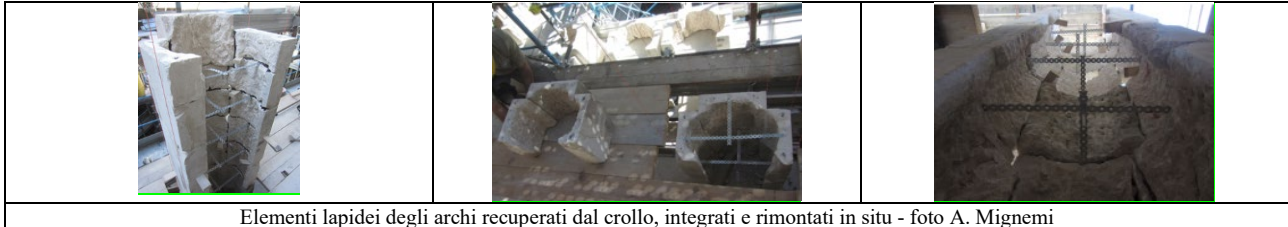
Elementi lapidei degli archi recuperati dal crollo, integrati e rimontati in situ - foto A. Mignemi
