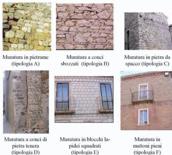
Figura 3. Esempi di alcune tipologie del campione.
