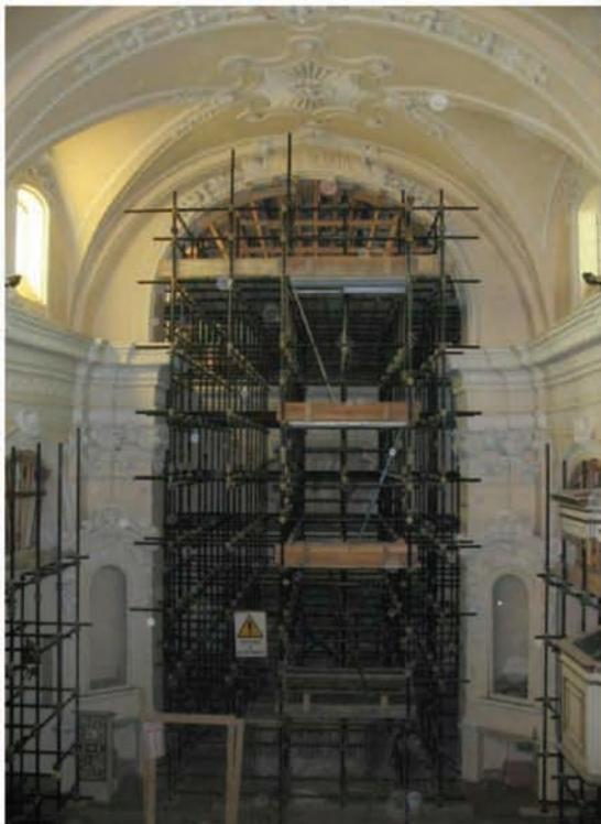
Puntellatura con elementi giunto-tubo a maglia quadrata e centinatura della volta con elementi lignei
