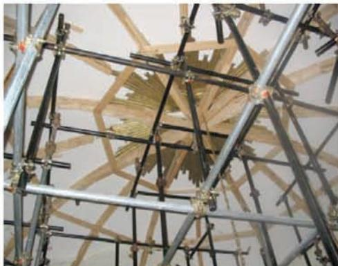
Figura 13 - Centinatura di volte con elementi lignei
