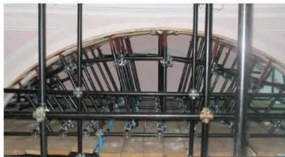
Figura 11. Sistemi di puntellatura di volte ed archi
