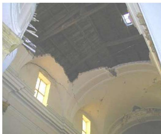
La risposta trasversale è evidenziata da lesioni gravi negli archi della navata centrale e dell’arco trionfale e dal crollo parziale della volta in mattoni forati della navata centrale. La vulnerabilità è dovuta prevalentemente all’assenza di catene trasversali e contrafforti e alla presenza di volte sottili.
