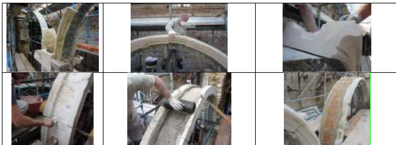
Fase di stuccatura dei conci; fase di consolidamento estradossale in fibra di basalto e malta di calce; inserimento di mattoni pieni allo scopo di ottenere una superficie piana pronta per la costruzione dell'arco a mattoni (strutturale) e volta a crociera - Foto A. Mignemi
