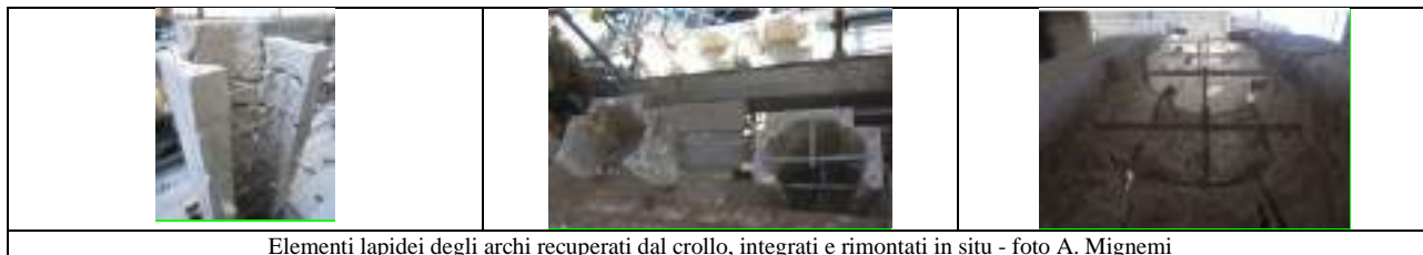
Elementi lapidei degli archi recuperati dal crollo, integrati e rimontati in situ - foto A. Mignemi
